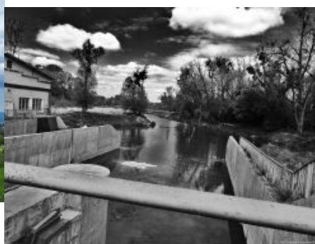
Elektrownia wodna na rzece Wieprz - Tarnogóra
